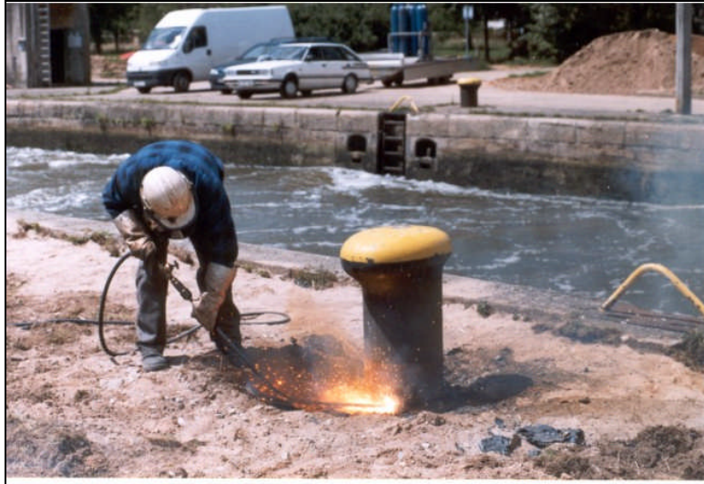
Abbildung 13: Abgeknicktes Brennrohr
