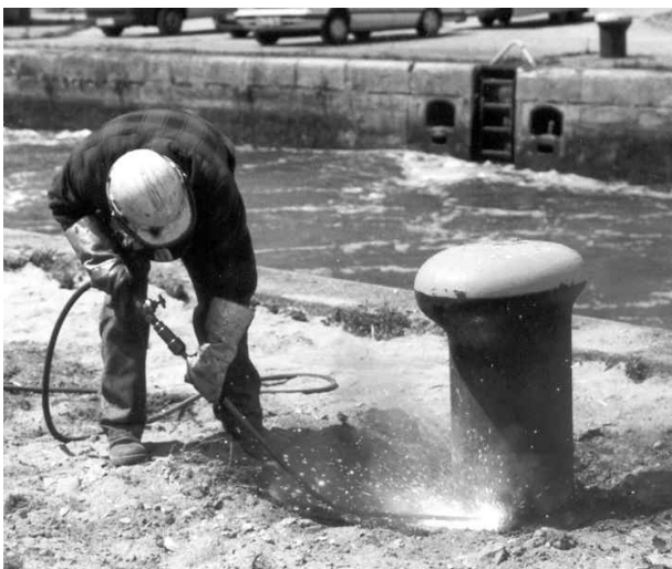
Bild 17. Zerschneiden des Metallmantels eines Pollers, gebogene Lanze.
