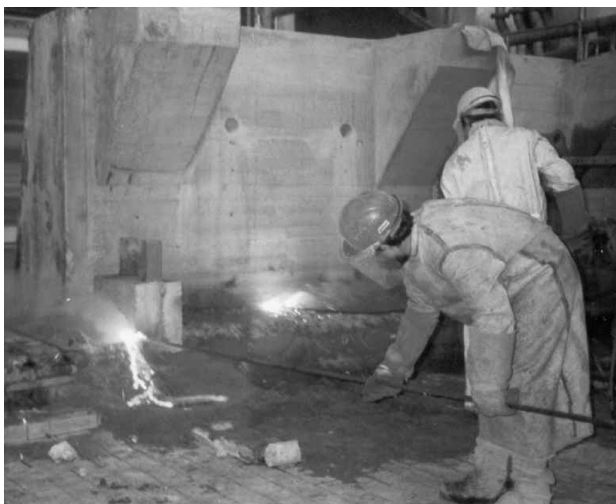
Bild 8. Zerschneiden von Betonstützmauern (mit zwei Lanzen).
